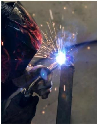
**Figura 33.** Soldadura de tapas de PTR del soporte.
